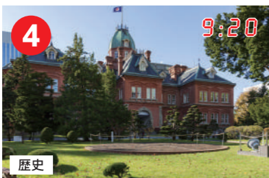
北海道庁旧本庁舎(赤れんが庁舎) 1888(明治21)年に建てられ、80年間本庁舎として使用されたアメリカ風ネオ・バロック式の建造物。館内に北海道の歴史資料も展示されています。※改修のため、2019年10月1日(火)から2024年度まで休館予定
