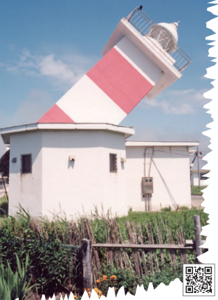
地震によって倒壊した青苗岬灯台
