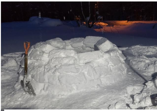
高さは円の半分程度、隙間はあまり気にせず、3・4・5段をつくる(最終的には6段でした)。5段目くらいのブロックは、4段目の上に積むというより、水をかけて4段目のブロックの側面に貼り付けるイメージになる。ブロックのつなぎ目に水をかけて接着剤のように作用させる。このため、この作業は氷点下で行う必要がある。5段目のブロックの立場からすると、下への支えはほとんどなく、あくまで下のブロックの側面に水をかけて凍らせて着いている状態になる。ただ、5段目が全周にわたって配置されると、5段目同志の側面でも繋がっているの、時間がたつと丈夫になるはず。同様に6段目をつける。
