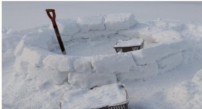
ブロック積み上げ1段目:内径に沿って円積する。上面を45°程度内側に傾斜つけて削っておく。1段目で買い物かごの大きさのブロックを12個使った。・2段目以降:徐々に内円傾斜と厚みを薄くする。2段目の1周で買い物かごのブロックを11個程度使った。
